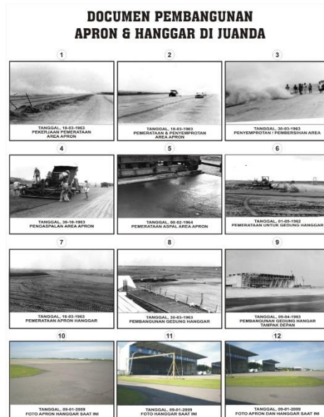
Gambar 2 Dokumen Pembangunan Apron dan Hanggar Juanda Sumber: Dinas Penerangan PUSPENERBAL Juanda
