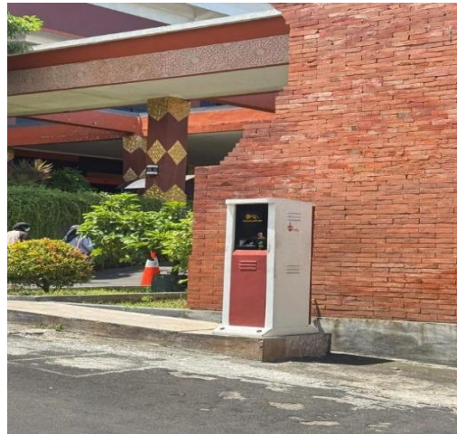
Gambar 5 Mesin Parkir Dinas Kependudukan dan Pencatatan Sipil di Mal Pelayanan Publik Gajah Mada.
